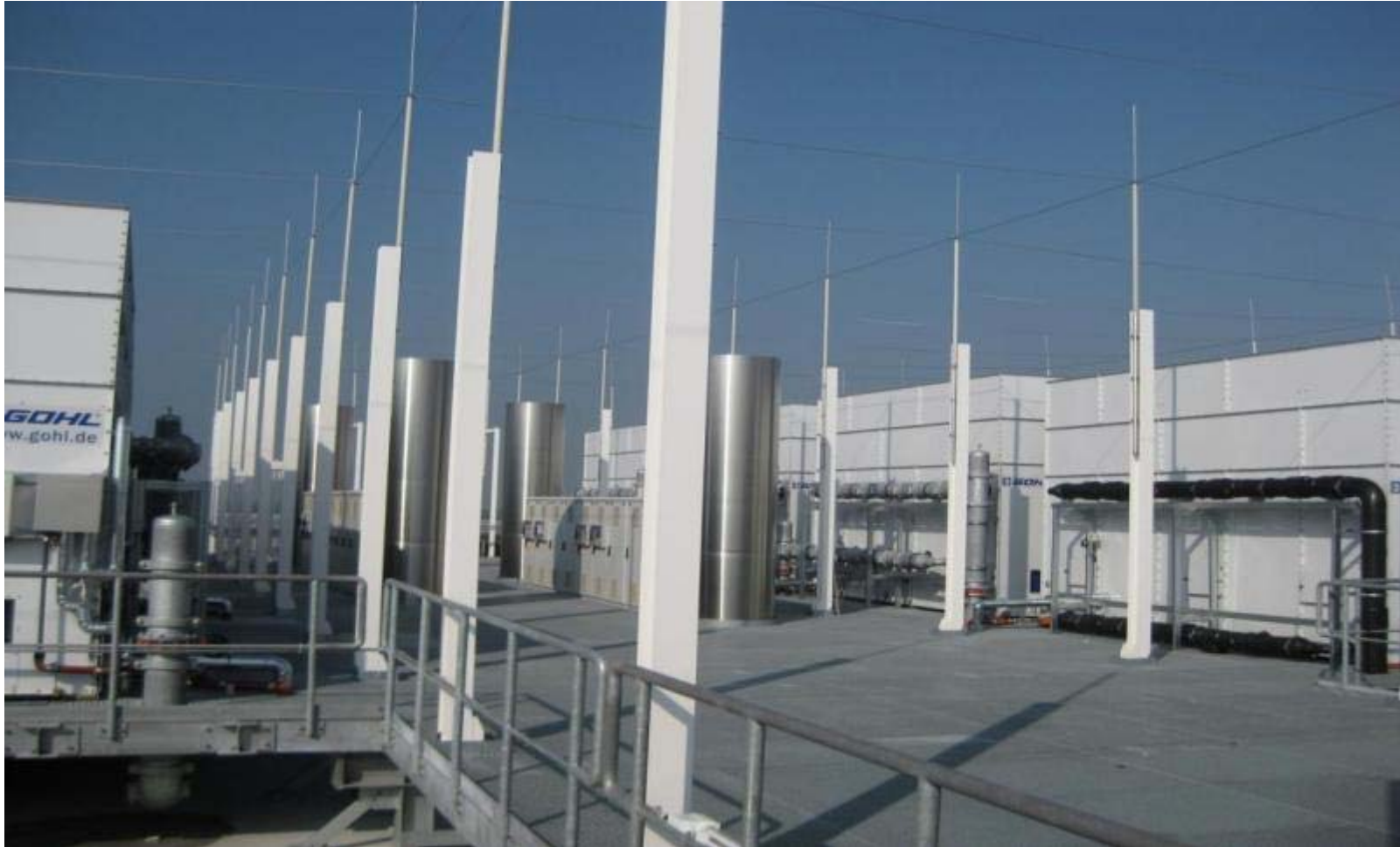
Picture: StBAM2 (staatl. Hochbauamt München 2)
