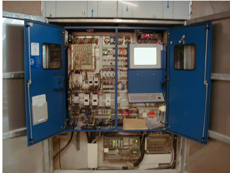
Abbildung 1.1: Steuerschrank mit eingebautem FA-PC
